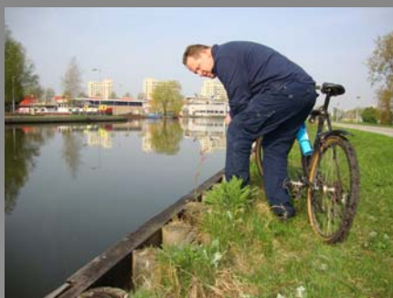
De onderzochte oeverconstructie
